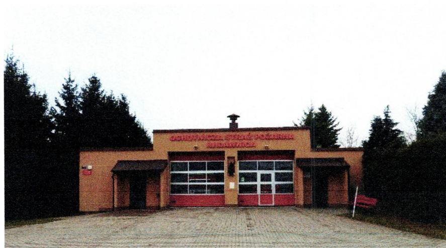
Zdjęcie 5 Budynek Ochotniczej Straży Pożarnej w Radawnicy wraz z częścią pełniącą funkcję świetlicy wiejskiej
